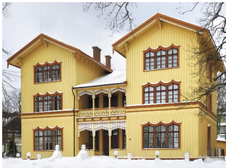
Fig. 1.5. Building tradition – fachwerk. Villa Flora, Kalno St 7, Juodkrantė (Ptašek, 2011)
