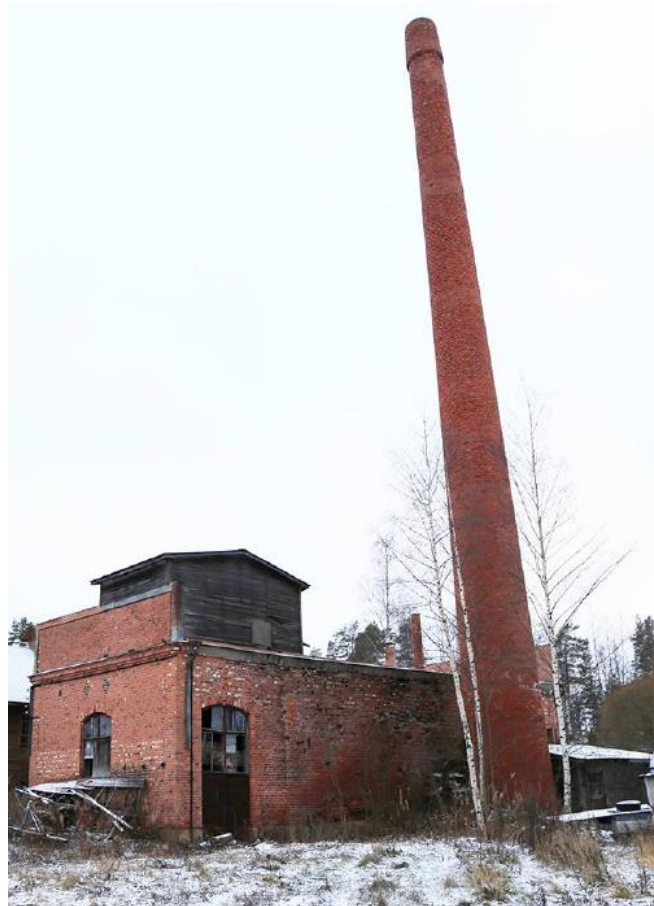
Figure 9. Power Station/ Voimalaitos
